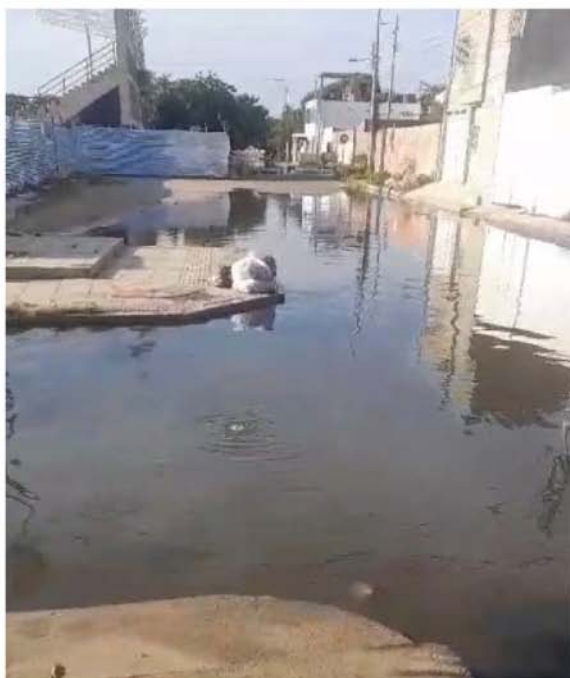
Aguas servidas en el barrio Arriba.
